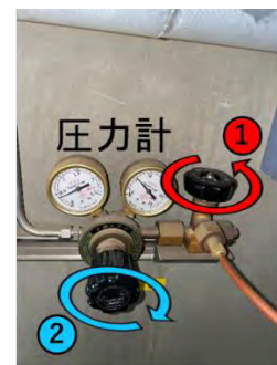
図3 バルブの開け方
