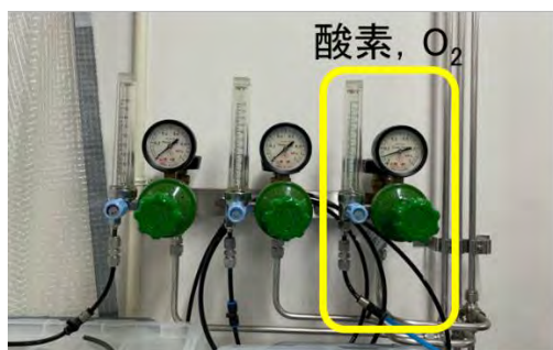
図11 先端での酸素供給バルブ
